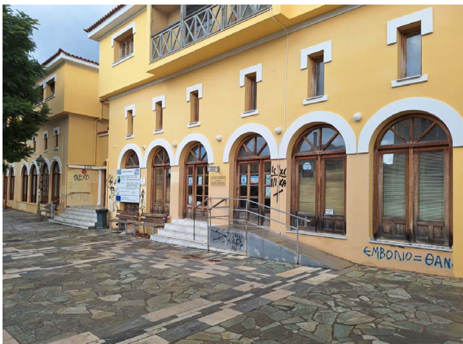
Εικόνα 3.7 Μεταλλική ράμπα εισόδου στη ΔΕΥΑΚ
