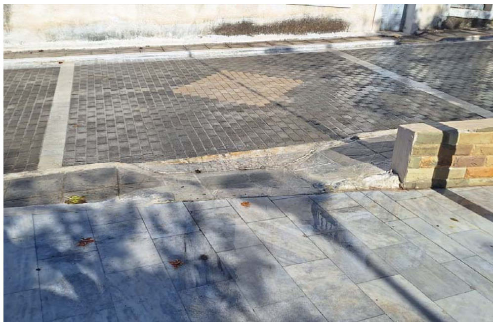
Εικόνα 3.53 Θέση ράμπας στην πλατεία Σπερχογείας
